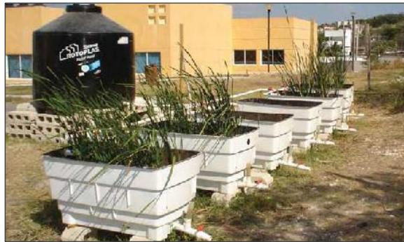
**Figura 19. Humedales de flujo subsuperficial vertical. (2005)**
