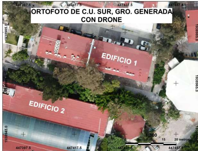
Figura 46. Ortofoto generada con drone, C.U. Sur, Facultad de Ingeniería, Edificio 1 (DRONExy).
