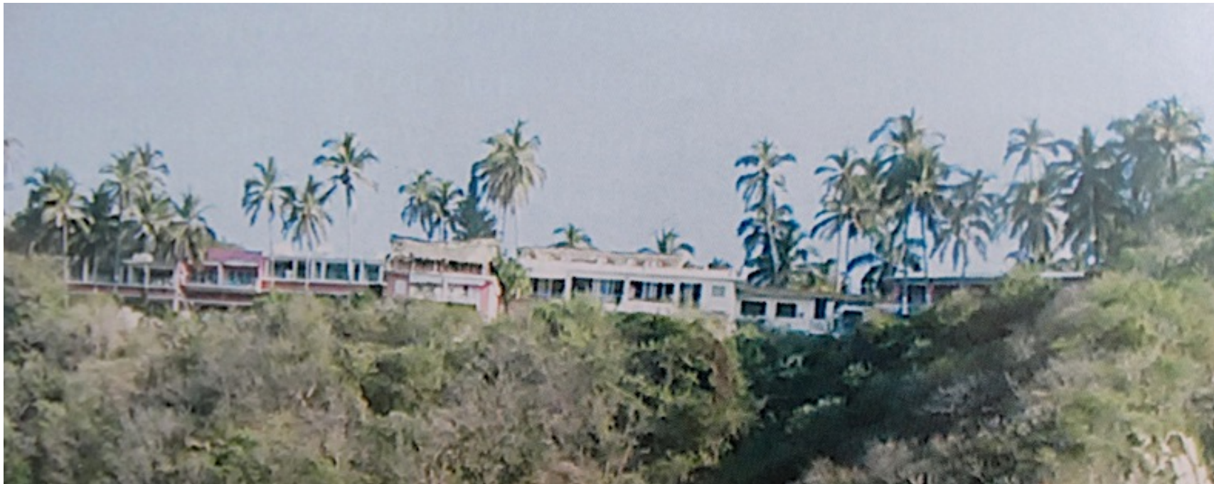
Ilustración # 6. Hotel Los Flamingos
