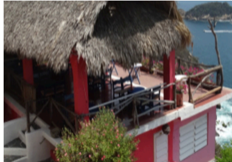
Fotografía # 35 barandales de madera Fuente. D. Adame Arcos 2015
