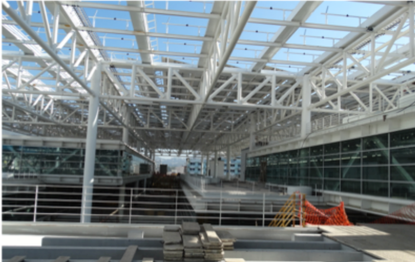
Fotografía # 21 Armadura de techo y barandales Fuente. D. Adame Arcos 2015
