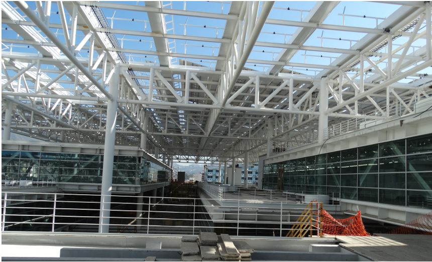
Fotografía # 8. Techumbre, barandales de acero Fuente. D. Adame Arcos 2015
