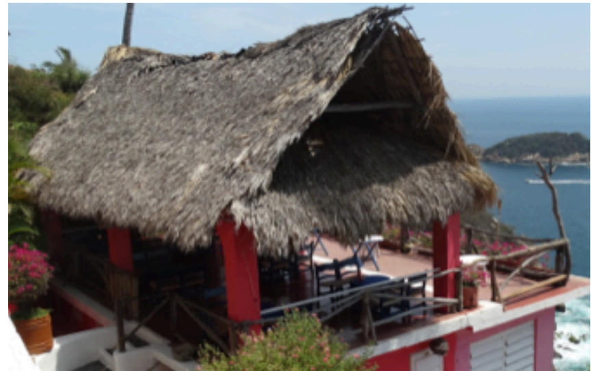
Fotografía # 33 cubierta de palapa Fuente. D. Adame Arcos 2015
