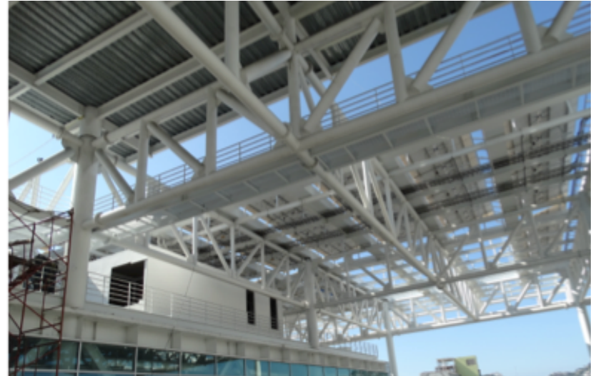
Fotografía #22 Estructura de techo
