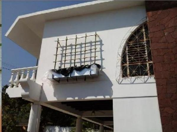
Fig.12 Estructura de bambú.
