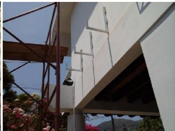
Fig. 8 Anclaje de los soportes.
