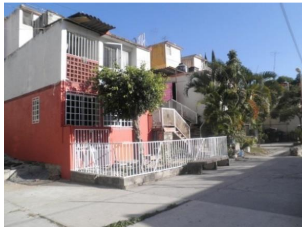
Figura 5.14. Ampliación de vivienda y apropiación del área común. Fuente: J.S.G., 2014.
