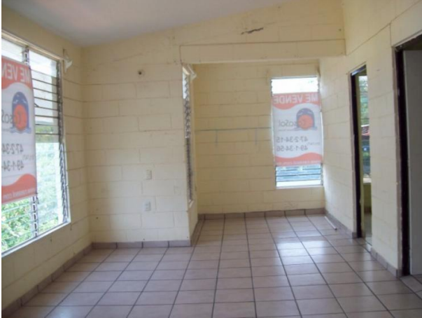
Figura 4.48. Vista de la sala hacia la ampliación.
