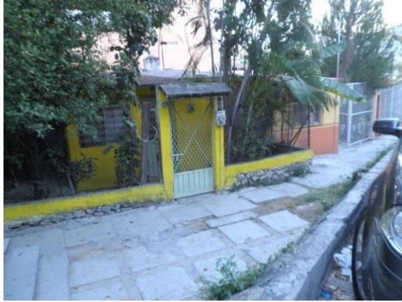
Figura 4.38. Vivienda unifamiliar modificada. Fuente: J.K.R.S., 2013.
