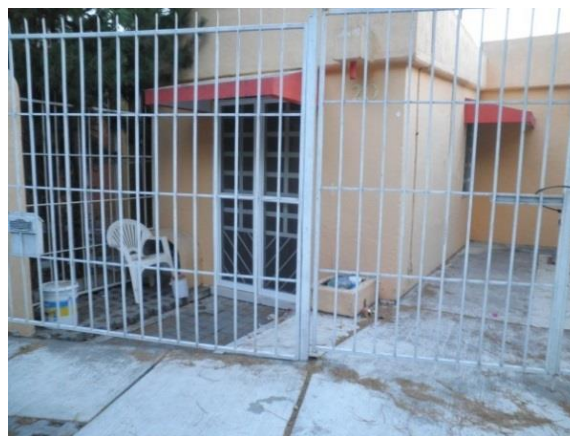
Figura 4.37. Vivienda unifamiliar modificada. Fuente: J.K.R.S., 2013.
