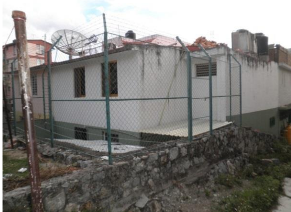
Figura 4.40. Vivienda dúplex original. Fuente: J.S.G., 2012.
