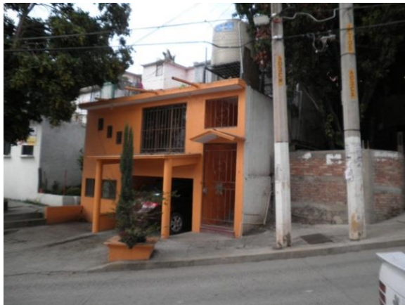
Figura 4.41. Vivienda dúplex transformada. Fuente: J.S.G., 2012.
