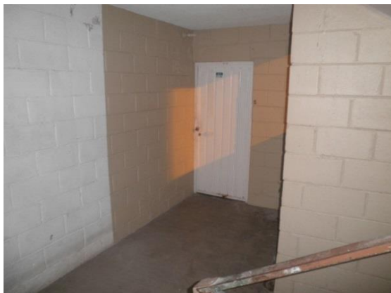
Figura 5.17. Área común en la zona de escalera. Fuente: J.S.G., 2014.
