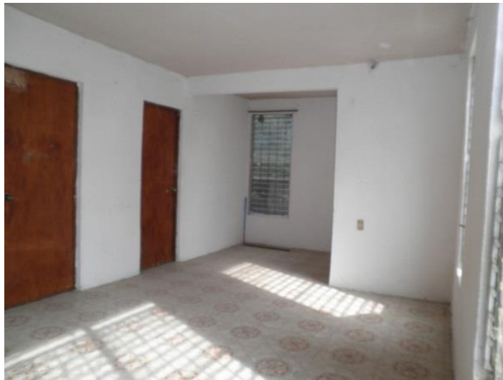
Figura 4.67. Vivienda 102, Edificio 13, Etapa III. Fuente: J.S.G., 2014.
