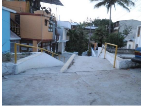
Figura 5.10. Construcción sobre el área común. Fuente: J.K.R.S., 2013.
