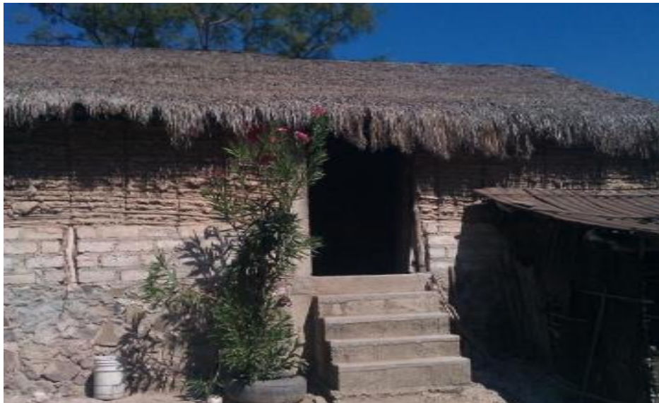
Construcción de viviendas Fotografía tomada: Azucena Rodríguez, 15 de octubre del 2016.
