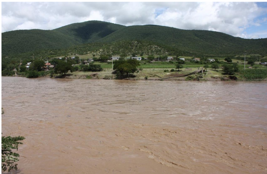
Fotografía 6. Caída del puente colgante
