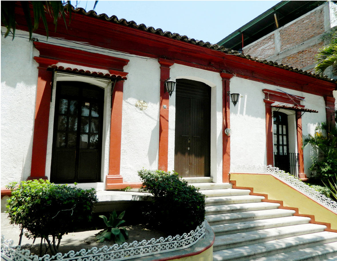
Figura 29. Imagen de la casa de la Fam. Catalán Vélez en el barrio de San Francisco Chilpancingo, Gro. Fuente propia 2016
