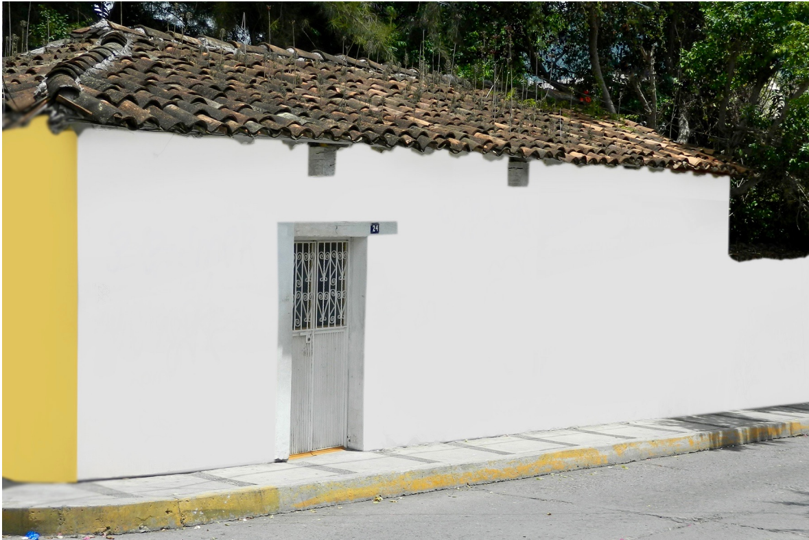
Figura 25. Imagen de la casa de la Fam. Memije Sales en el barrio de San Mateo Chilpancingo, Gro. Fuente propia 2016
