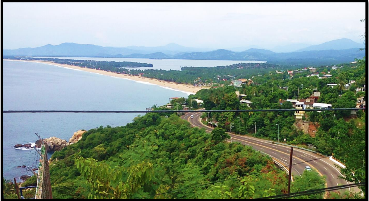
Fotografía 6. Ampliación a cuatro carriles de la carretera Mozimba – Pie de la Cuesta. Fuente: Propia.
