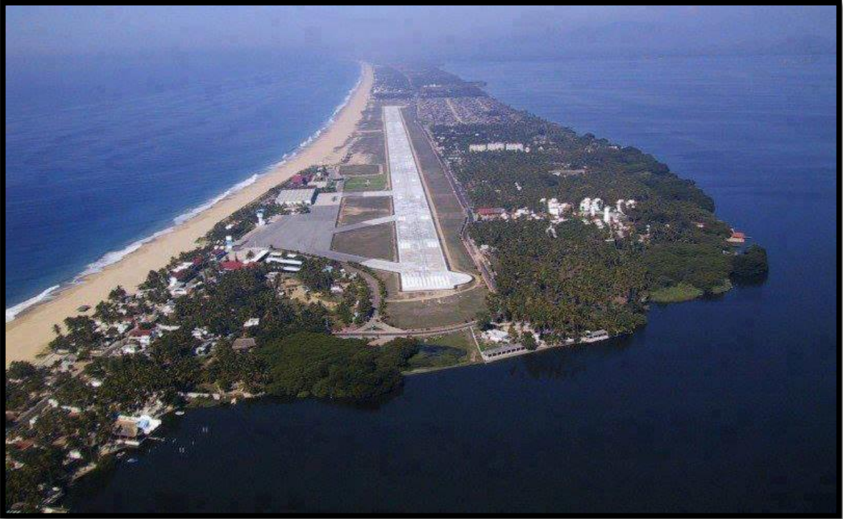
Fotografía 5. Vista aérea actual de la BAM-7.
