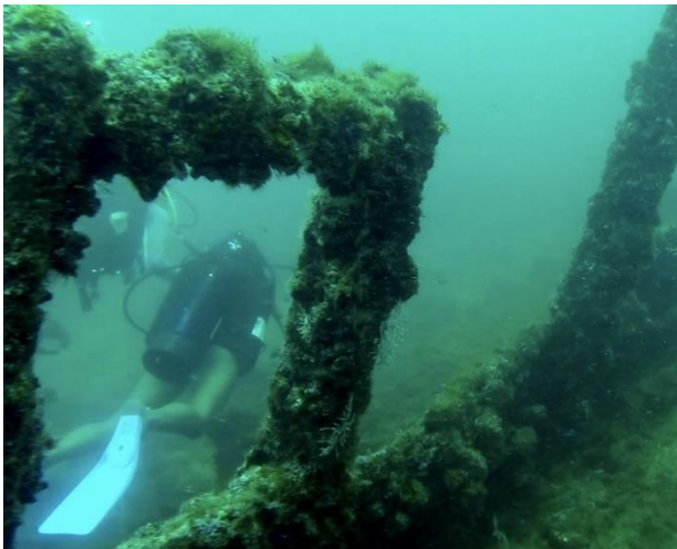
Imagen 4. Estructura perteneciente al casco del Corsario (fuente personal).
