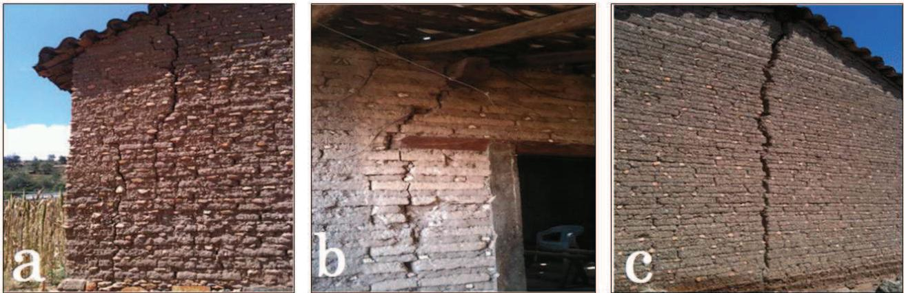
Figura 4. Agrietamientos: a) esquinas de muros, b) esquinas de vanos, y c) zona central de muros. Fotografías: R. Arroyo Matus
