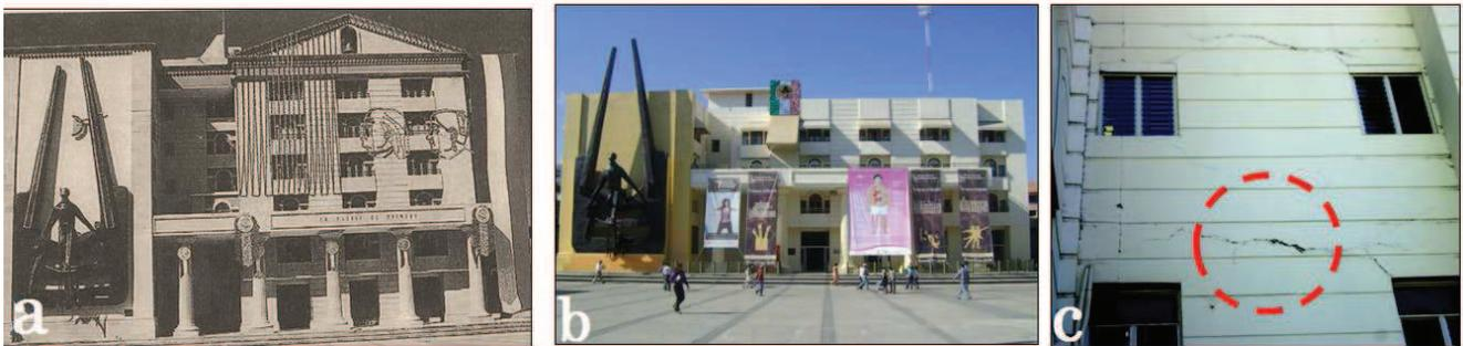
Figura 7. Fachada principal del Palacio de la Cultura; a) 1990. Fotografía: H. Suástegui Salmerón, b) 2012. Fotografía: R. Arroyo Matus y c) Agrietamiento por torsión de traves de la fachada norte, inducidas por la flexión excesiva de losas planas, Palacio de la Cultura. Fotografía: R. Arroyo Matus.
