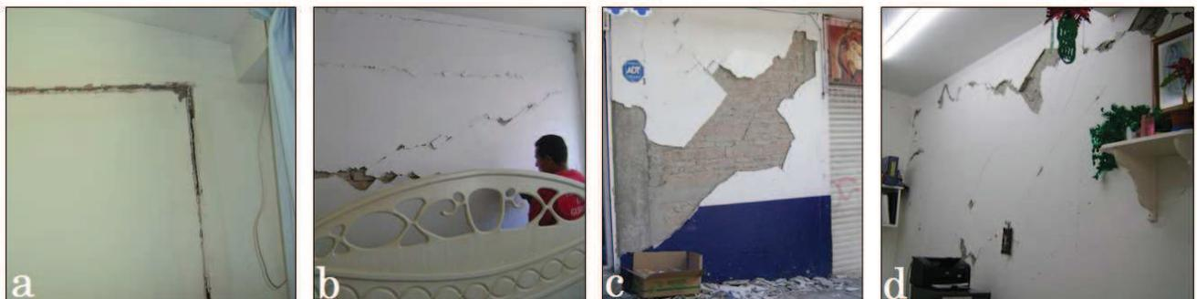
Figura 13. a) Separaciones de muros divisorios de los marcos de concreto, b) fisuras por cortante, c) Daño moderado por tensión diagonal en muros de mampostería y d) por desprendimiento del extremo superior en muros divisorios, en el Centro de Chilpancingo, Gro. Fotografías: SEPC
