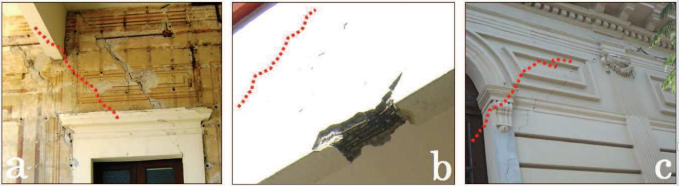
Figura 6. Daños en el Museo Regional de Guerrero: a) Agrietamiento severo por cortante en dinteles y muros de mampostería. Esquina noreste, muro interior. b) Agrietamiento severo por cortante, con pérdida de recubrimiento, en traves del corredor noreste, y c) Agrietamiento severo de cortante en la fachada norte, producido por el desacoplamiento de sus alas oriente y norte. Fotografías: R. Arroyo Matus.
