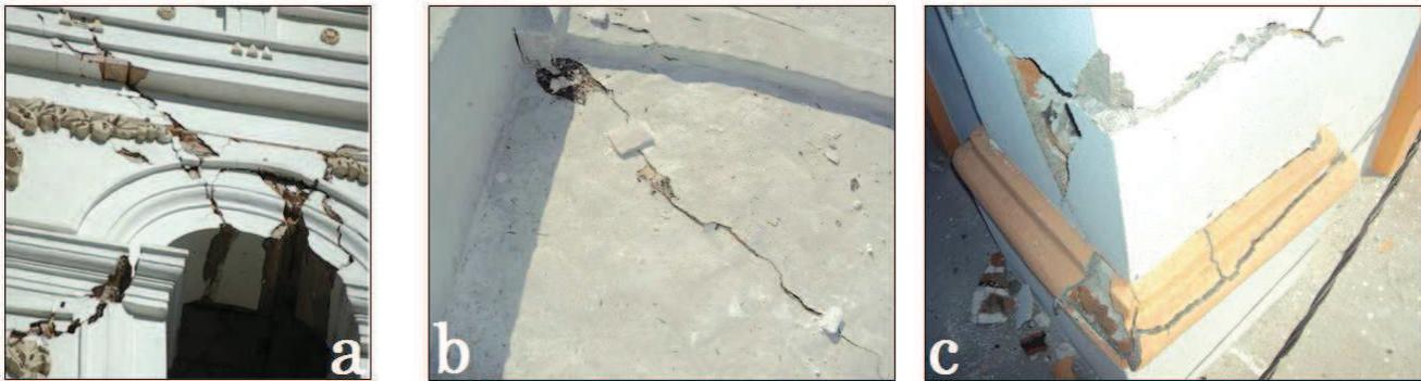
Figura 9. Templo de la Asunción a) Detalles de daño en los recubrimientos de la torre norte. Fotografía: P. Catalán Quiroz, b) en la cubierta abovedada. Fotografía: R. Arroyo Matus y c) Templo de San Antonio con daño por flexión en la base de las columnas de los arcos. Fotografía: SEPC
