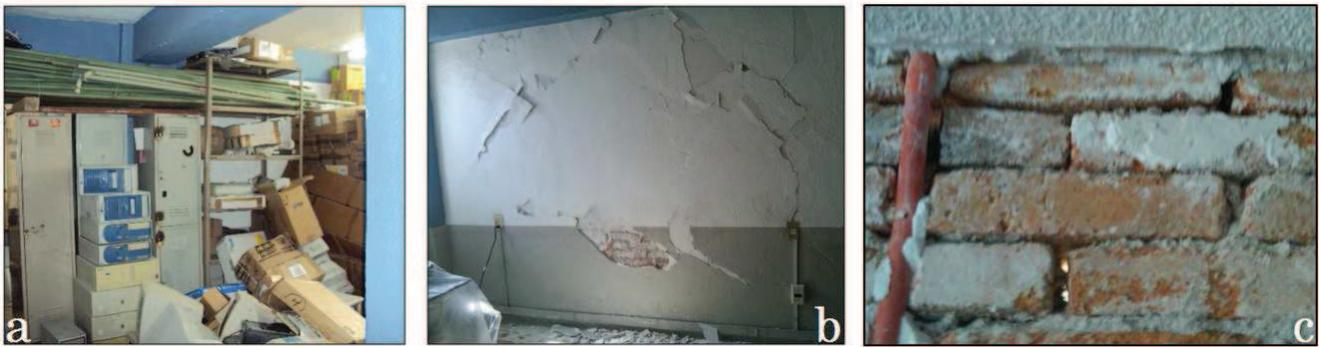
Figura 14. a) Acumulación excesiva de material y archivos en entresijos, b) daño en muro de mampostería, y c) junta inadecuada entre piezas de mampostería. Edificio Telecomm, Chilpancingo. Fotografías: Tizoc Calleja
