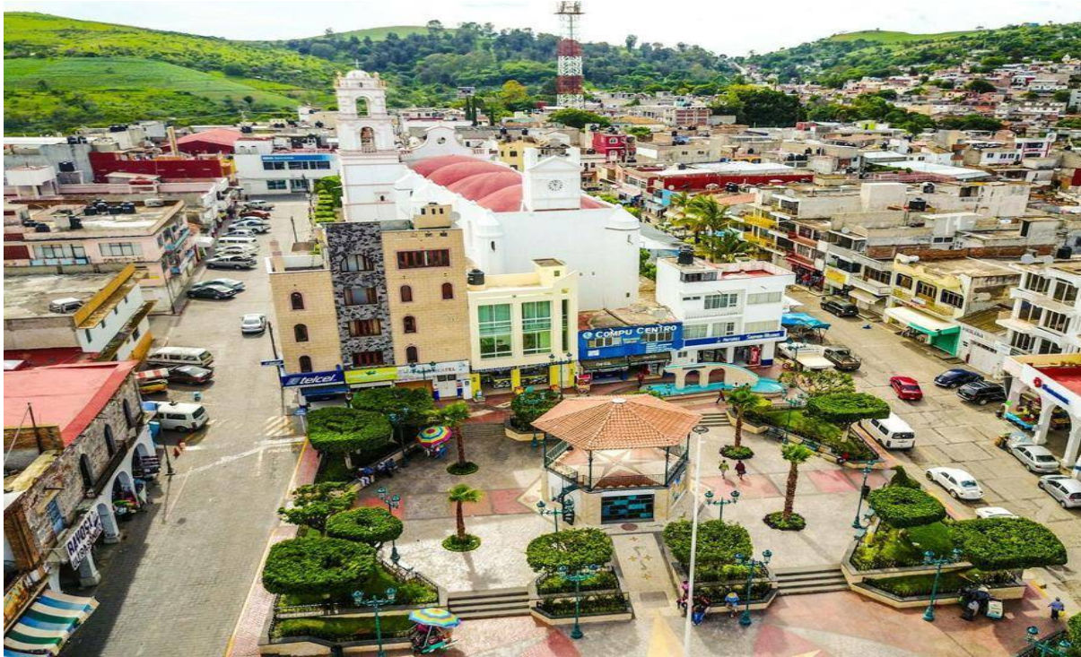
Fotografía 22: Vista aérea de la plaza principal.
