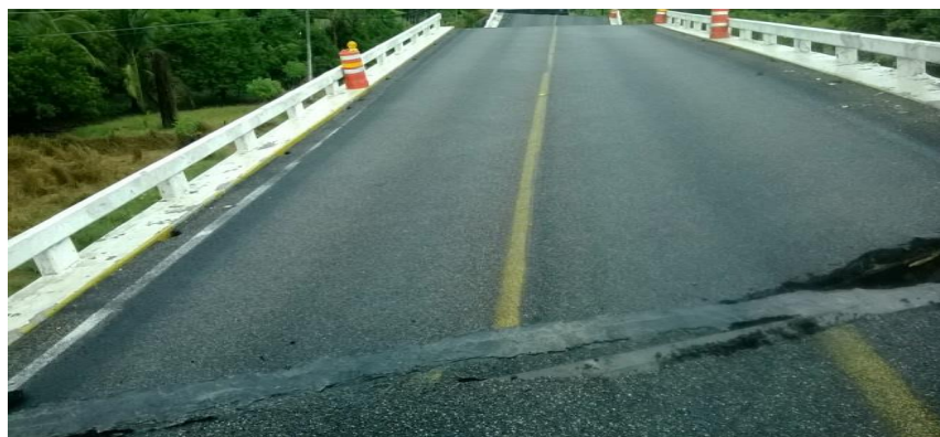
Figura 2.19 Sismicidad. Puente El Cuajilote.
