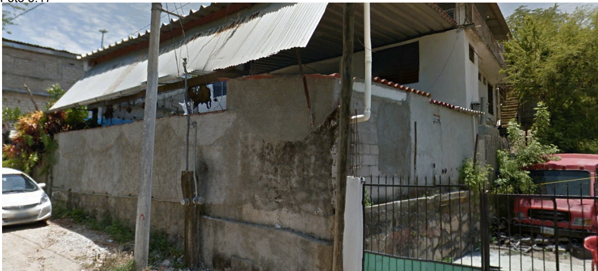
[Foto 5.16 – 5.17] Fuente: Google Earth (12-13-2015). Calle Roble, Esquina Calle Joviero y Ciruelos , Calle del Mango, todas las imágenes pertenecen a la Col. Zapata
