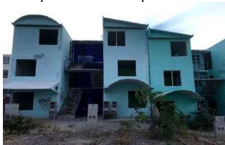
Figura 3. Departamentos en espera de ser demolidos
