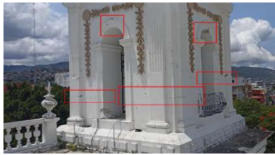
Figura 5. Grietas en base de la torre – campanario norte. Fuente propia.
