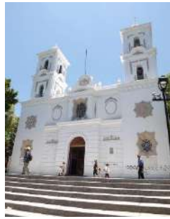
Figura 1. Fachada principal de la catedral. Fuente propia.
